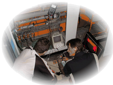
Bei der Inbetriebnahme
